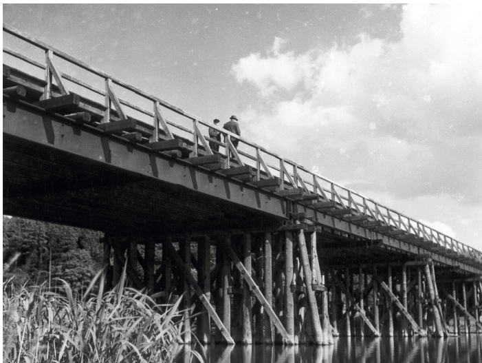
Ruhrbrücke bei Wickede-Ruhr Gesprengt am 08.04.1945 durch deutsche Soldaten. Zwischenzeitlich Notbrücke der US Soldaten und anschließend Wiederaufbau durch US-Pioniere.
